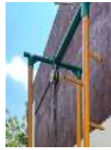
Figura 4.- Corona soporte de estructura tubular
