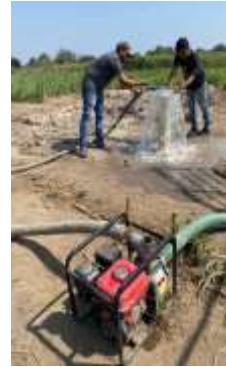
Figura 11.- lavado de pozo
